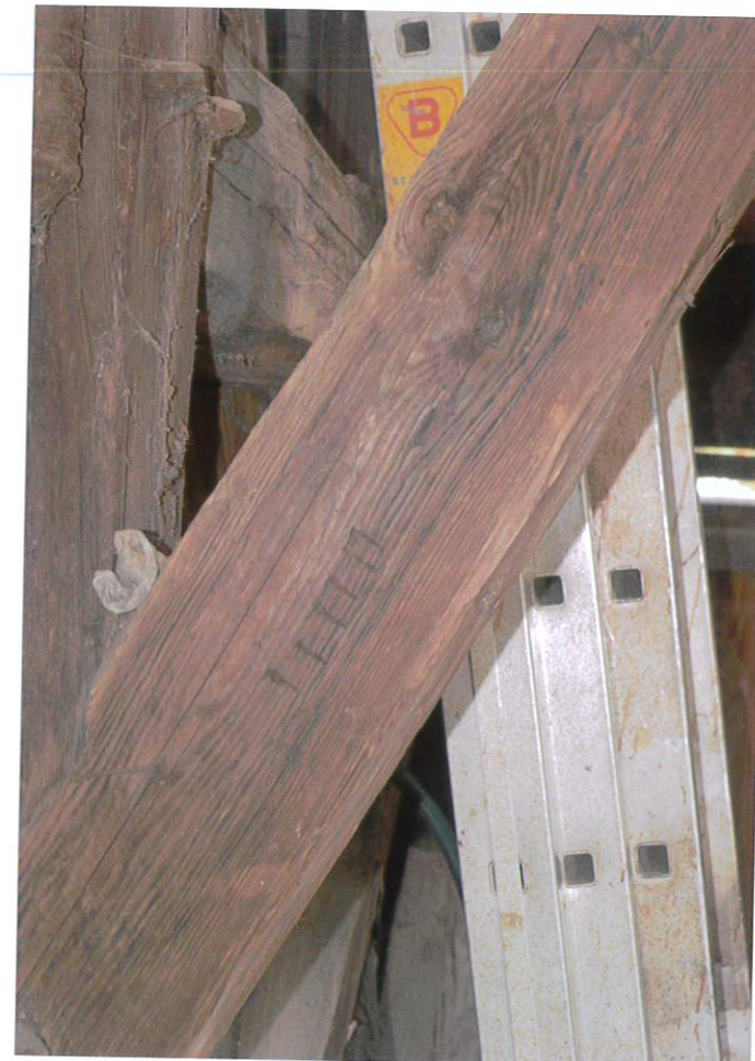
Fot. 10. Rama północna – fragment zastrzału ze znakiem montażowym, 2022..
