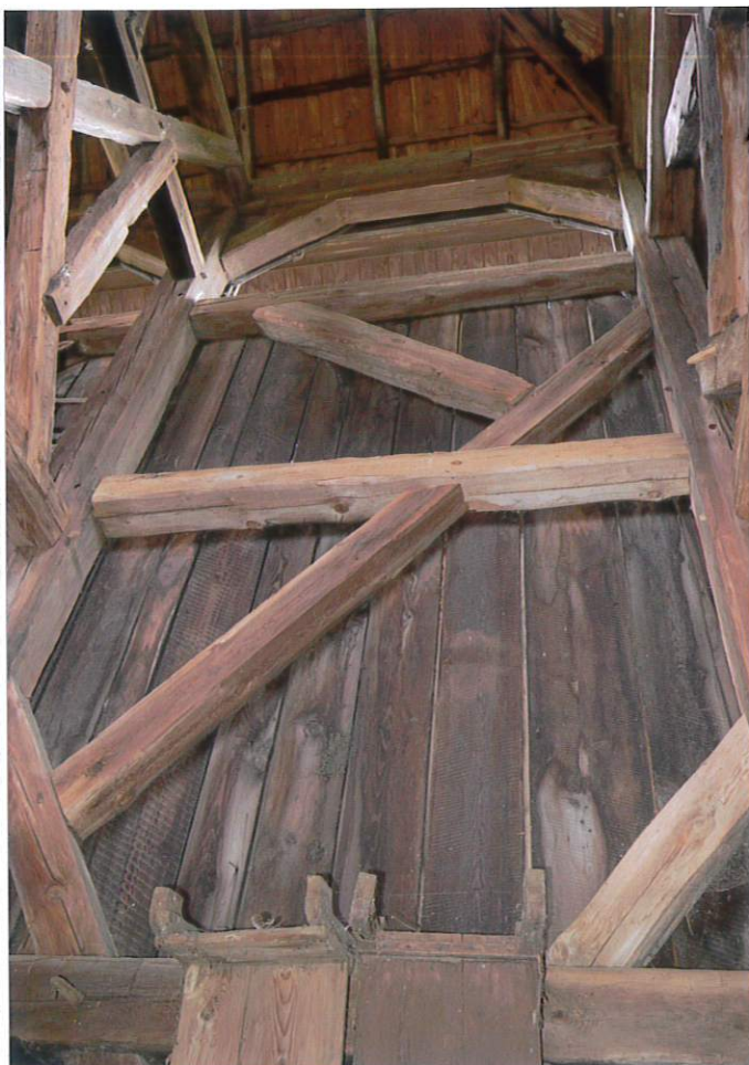
Fot. 15. Ściana północna (północno-wschodnie przęsło), 2022.
