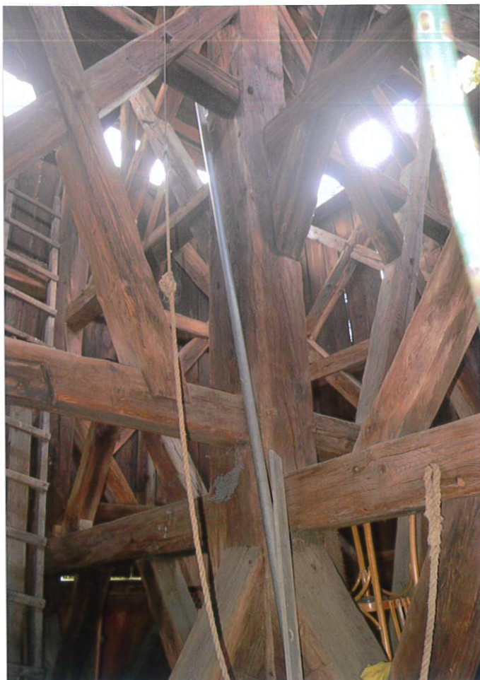
Fot. 8. Przęsło północno-zachodnie – widok na słup środkowy, 2022.
