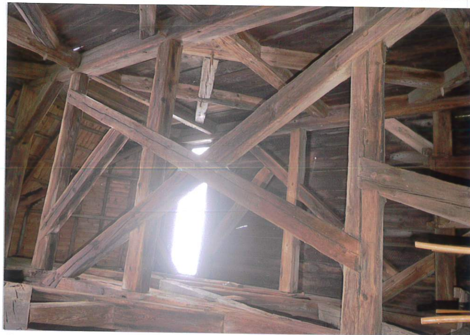
Fot. 7. Rama południowa (widok od zachodu), 2022..
