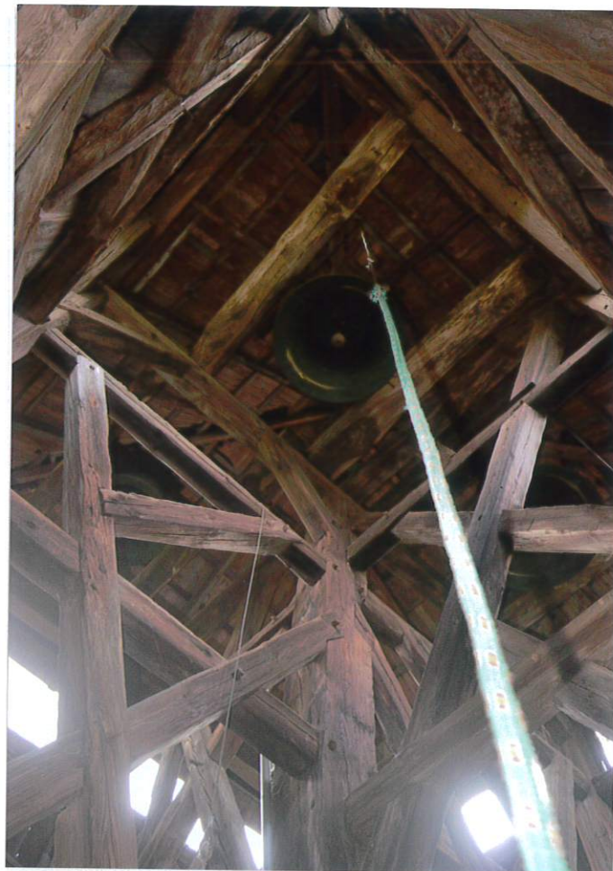
Fot. 9. Górne poziome przęsła północno-zachodniego wraz z dzwonem, 2022.
