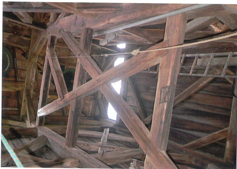
Fot. 6. Rama północna (widok od zachodu), 2022..
