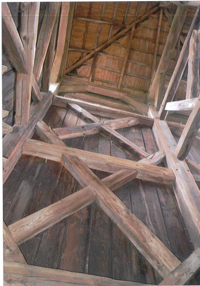
Fot. 16. Ściana wschodnia (północno-wschodnie przęsło), 2022.
