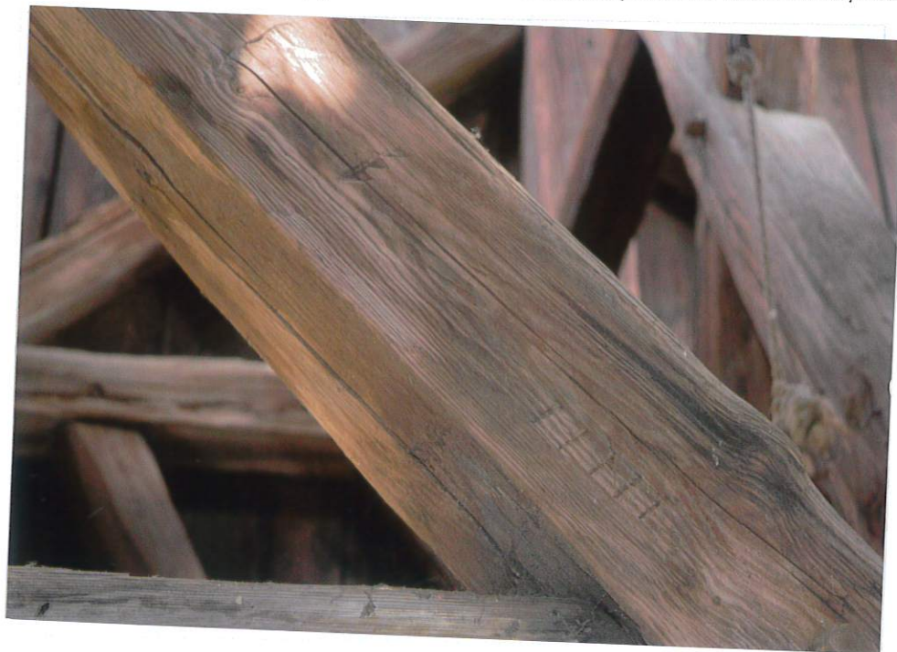
Fot. 13. Rama zachodnia – fragment miecza ze znakiem montażowym, 2022..
